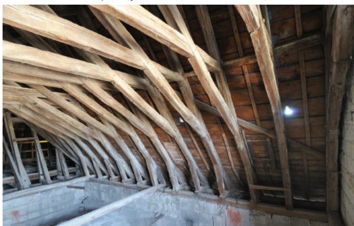
Fig. 9. Tours (Indre-et-Loire), église Saint-Julien, charpente du bras nord du transept (cl. J. Noblet, F. Tournadre)
