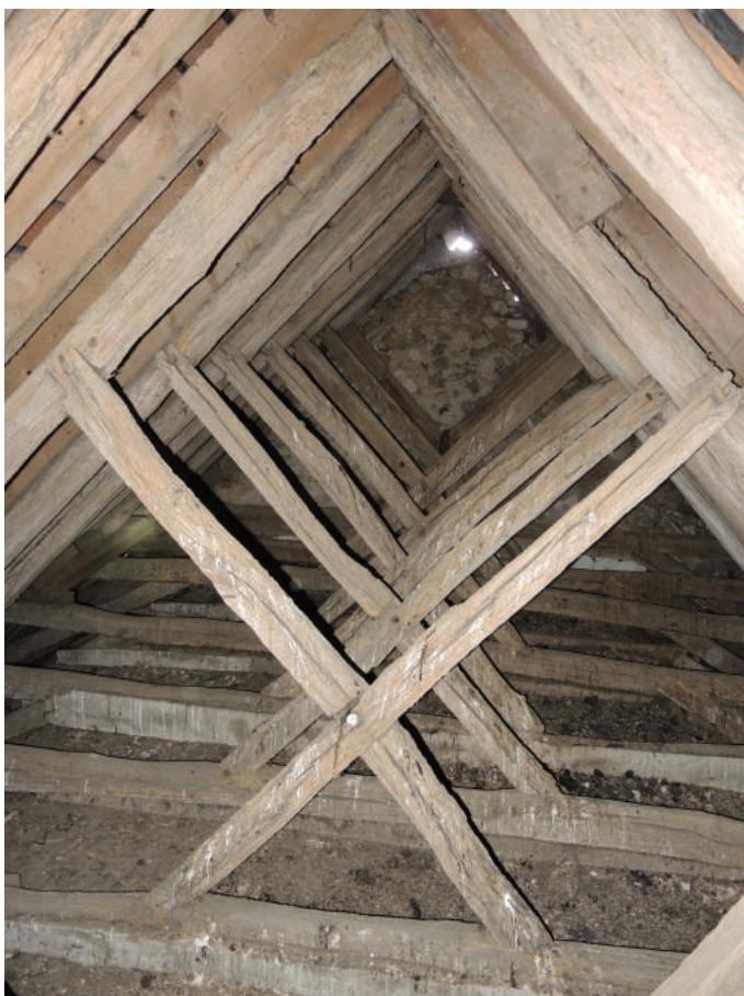
Fig. 3. Autrèche (Indre-et-Loire), église Saint-Martin, charpente de la nef, structure orientale (cl. J. Noblet, F. Tournadre)
