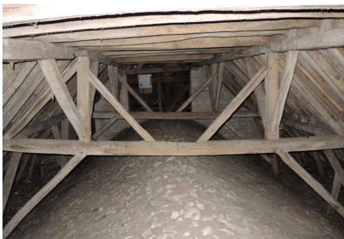
Fig. 8. Paulnay (Indre), église Saint-Martin, charpente de la nef (cl. J. Noblet, F. Tournadre)
