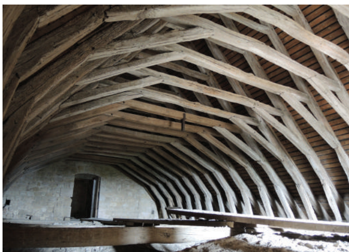
Fig. 10. Boiscommun (Loiret), église Notre-Dame, charpente du chœur (cl. J. Noblet, F. Tournadre)
